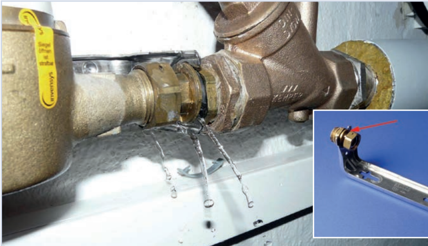
Leckage an einem Wasserzähler. Das kleine Bild zeigt eine Anschlussgarnitur von Beulco. Der Pfeil markiert die Schwachstelle am Gewindestutzen.
